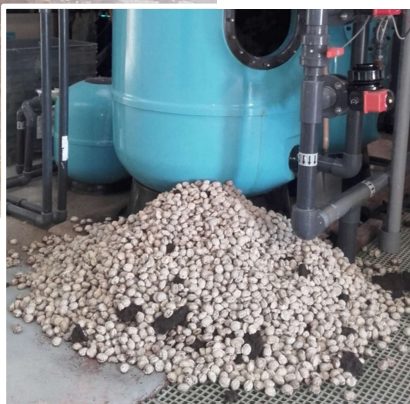
Biofiltre bactérien \text{NH}_3 + \text{O}_2 \rightarrow \text{NO}_3
